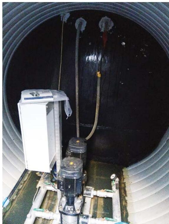
PE vodospreme i prekidne komore se isporučuju gotove sa atestom o ispitivanju vodonepropusnosti direktno na gradilište. Time se štedi na vremenu i isključuje mogućnost pogreške prilikom izgradnje takvih komora. Kod većih dimenzija vodosprema se rade na modularnom principu.
